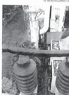
นกบินเมื่อส่งผลกระทบต่อหม้อแปลงไฟฟ้าแรงสูง
